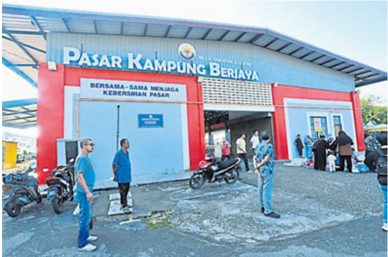
■米都甘榜不再也巴剎提升及維修工程預計在10月8日竣工。
